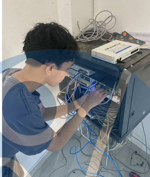
Gambar 4.4 Penarikan kabel dari rak server (Sumber: Dokumen Pribadi)
